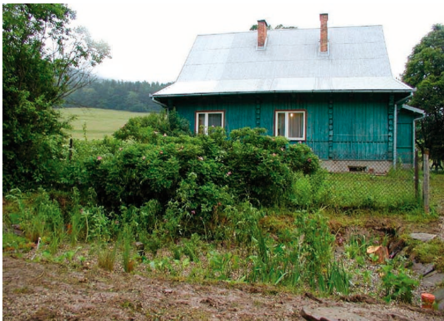
Przydomowa roślinna oczyszczalnia ścieków — Krempna, Magurski Park Narodowy
